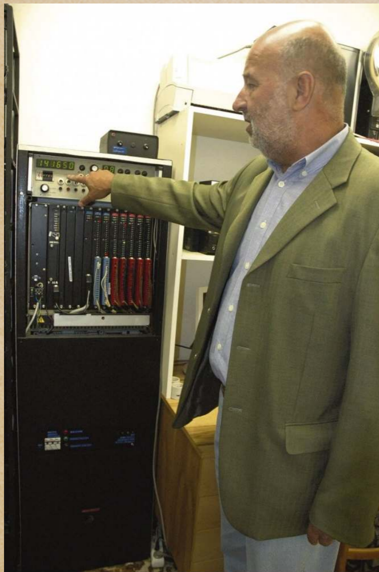
„V dnešní době musí být celá mechanika provozu fontány řízená počítačem. Na něm jsou nastaveny časy a skladby, které v danou hodinu spustí celý program,“ vysvětluje provoz fontány Rudolf Petrák ze společnosti Léčebné lázně Mariánské Lázně, a. s., která se o fontánu stará. Rudolf Petrák ukazuje důležitá čísla na mixážním pultu. Jedná se časové údaje.
